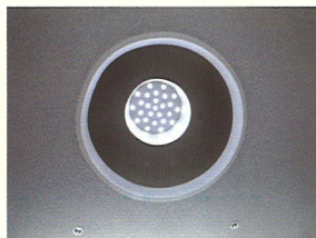
1 階東廊下 トップライト
